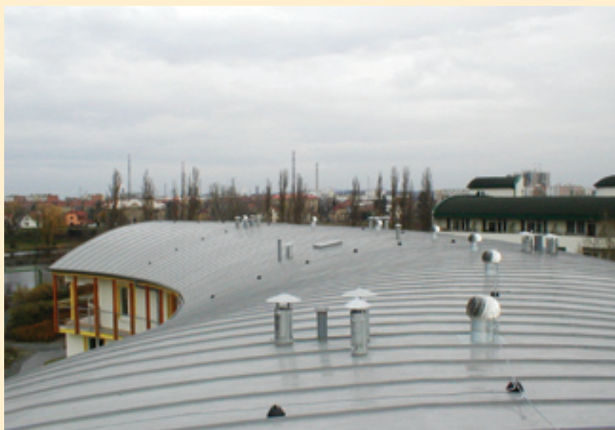
Hydroizolační fólie typu mPVC Rhenofol CV s dekoračními profily. Dům s pečovatelskou službou, Kralupy nad Vltavou
