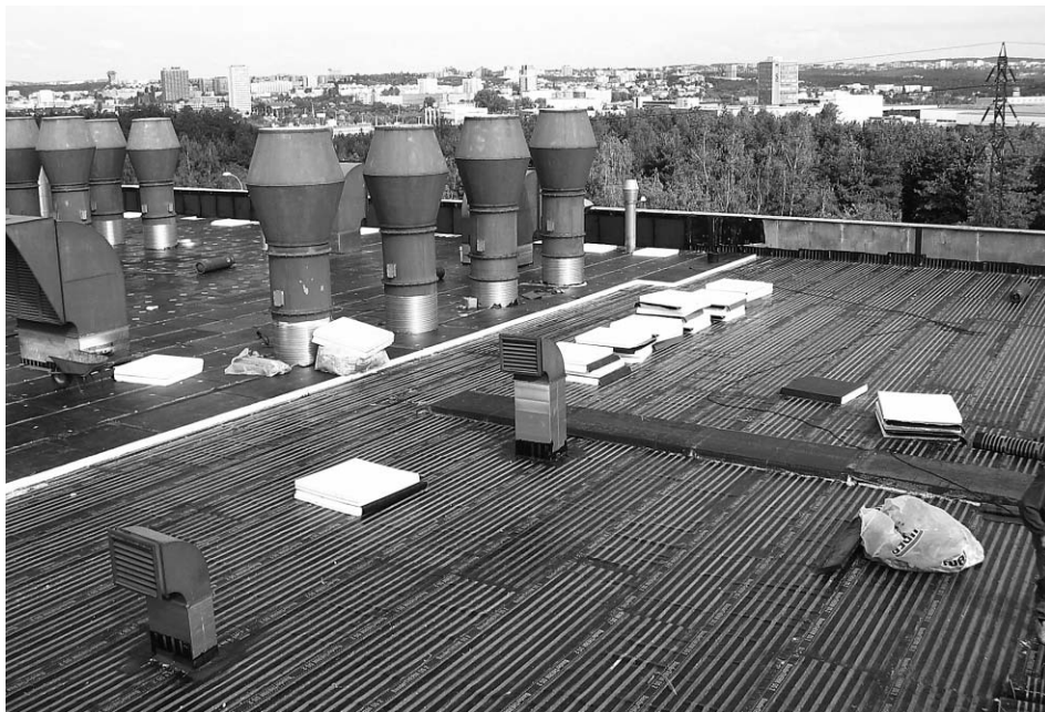
Rozpracovaná střecha s parozábranou Bauder-THERM DS2
