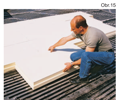
pokládka na samolepící bitumen.pásky
