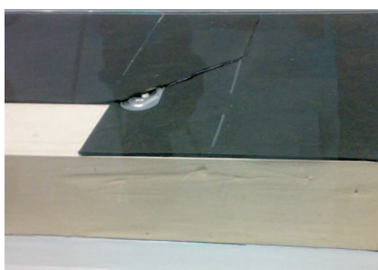
přesah dvou vrstev hydroizolace+kotva
