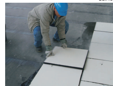
lepení do asfaltu
