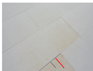
Příklad spárové netěsnosti
