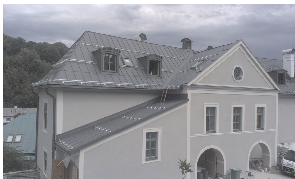
Obr.42 - montáž plechové střechy - titanzinek
