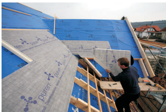
Obr.41 - montáž úžlabí
