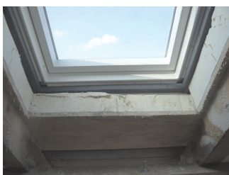
Obr.22 - pracovní otvor pro střešní okno
