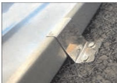
Obr.30 - struktur.rohož+příponka krytiny
