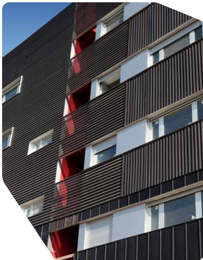
Bytový dům, Vulpalleras (Španělsko) Foto: Paul Kozlowski Architekt: EMBA Estudi Massip-Bosch VMZINC® Panel sinus ANTHRA-ZINC®
