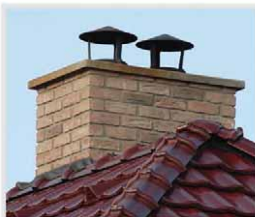
Realizace Základní nadstřešní části obloženou obkladovými pásky
