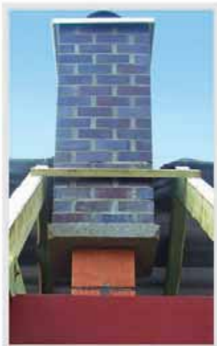
Realizace komínové hlavy obezděné lícovými cihlami
