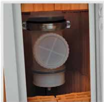
Založení a ukotvení CIKO GAS
