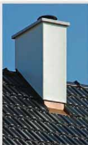
Realizace návleku ŠTUKO
