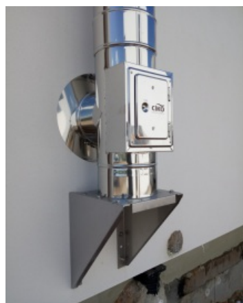
Fasádní komín na konzoli s dvířkovým dílem
