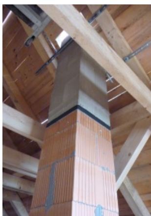
Přerušení tepelného mostu v úrovni stropu
