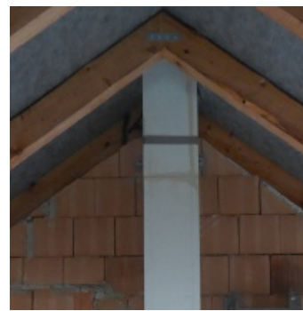
Průběžné kotvení stěnovým úchyttem
