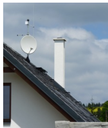
Omítnutá základní nadstřešní část
