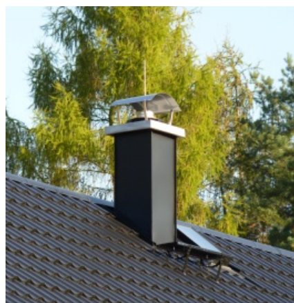
Oplechovaná základ nadstřešní část s oblou stříškou
