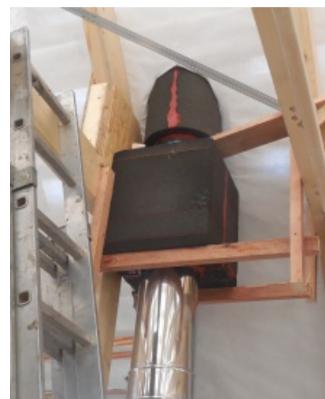
Parotěsné prostupy na nerezovém komíně
