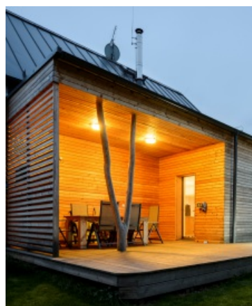
Novostavba s nerezovým komíнем
