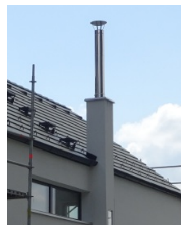
Nerezový nástavec založený nad střechou
