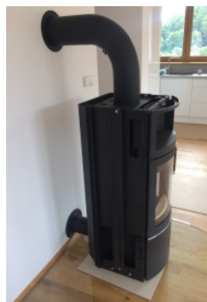
Napojení kamen na přívod vzduchu
