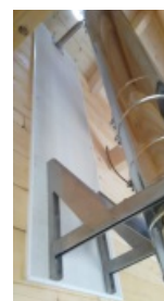
Založení na stěně
