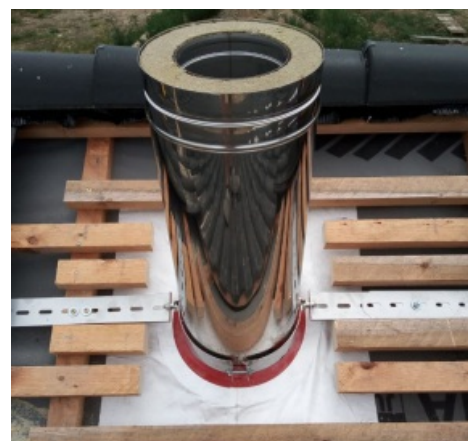
Využití těsnící manžety HotSchott a střešního držáku
