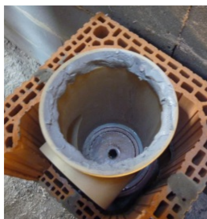
Spárovací hmota v hrdle vložky CIKO TEC
