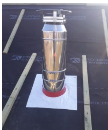
Manžeta HOTSchott nalepená k pojistné hydroizolaci
