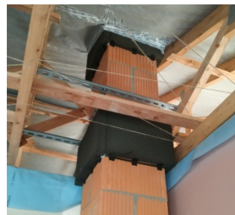
Parotěsné prostupy na cihelném komíně
