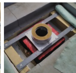
Detail založení v ploché střeše
