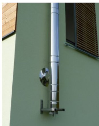
Fasádní komín na konzoli s čištěním spodem
