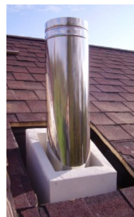
Realizace s nerezovým nástavcem
