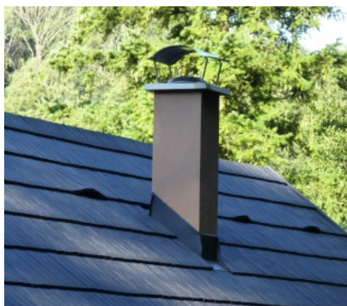
Omítnutý základ s oblou stříškou
