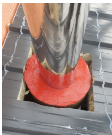
Parotěsný vstup zatřený záruvzdorným silikonem
