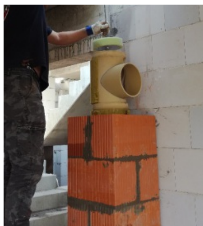
Čištění spojů CIKO TEC
