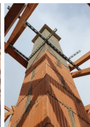
Kotvení komínu CIKO ke krovu
