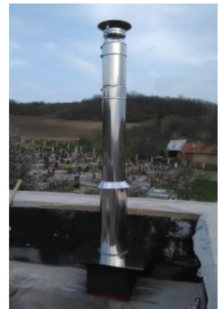
Prostup a vysoké lemování na ploché střeše
