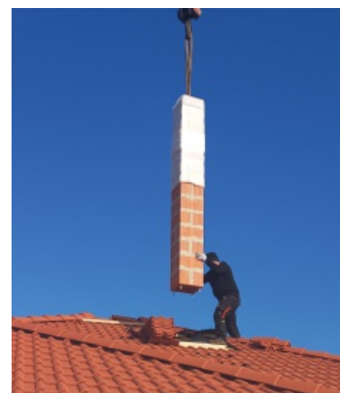
Instalace systému monoTEC pomocí jeřábu
