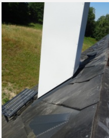
Detail přesazení návleku štuko přes lemování
