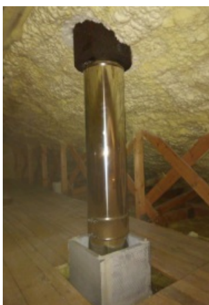
Přechod na nerezový nástavec
