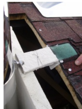
Příklad uchycení střešního držáku
