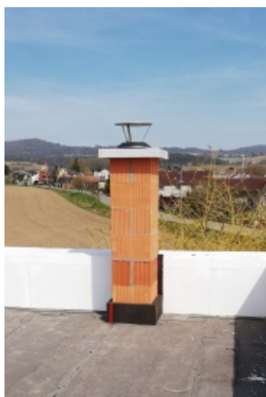
Parotěsný vstup plochou střechou
