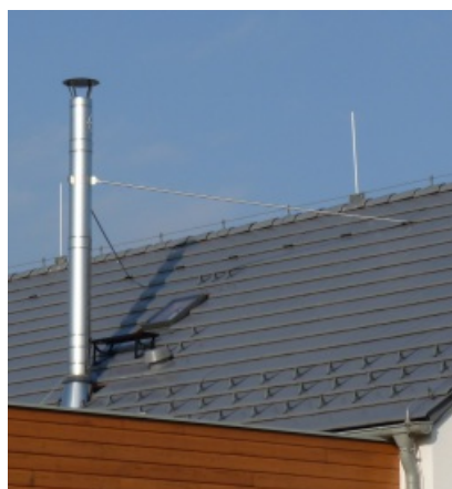
Kotvení komínu pomocí teleskopických tyčí
