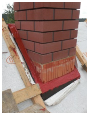
Parotěsný vstup cihelného komína
