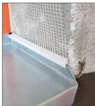
Foto realizace připojovacího profilu HPI - UNI
