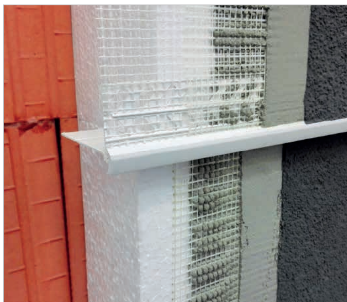
Profil s okapnicí a tkaninou přechodový (850-20)
