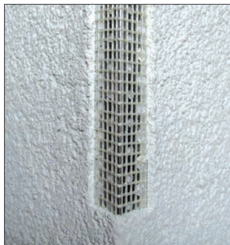
Detail umístění kombi lišty - řez
