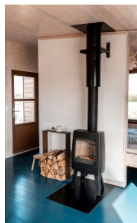
Lakovaný svislý kouřovod s funkcí komína
