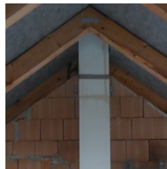
Průběžné kotvení stěnovým úchytem
