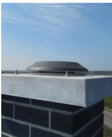
Krycí deska s přívodem vzduchu
