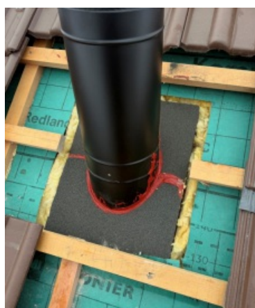
Parotěsný průstup GPKS v šikmé střešní konstrukci
