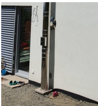
Komín založený na krátkitelném podstavci
