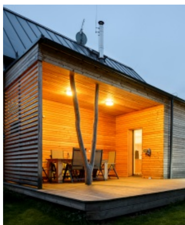
Novostavba s nerezovým komínem
