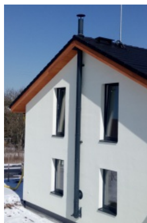
Lakovaný fasádní komín
