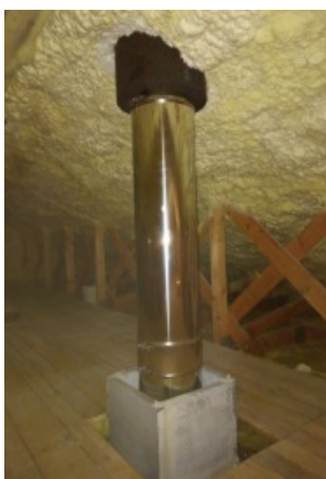
Přechod na nerezový nástavec
