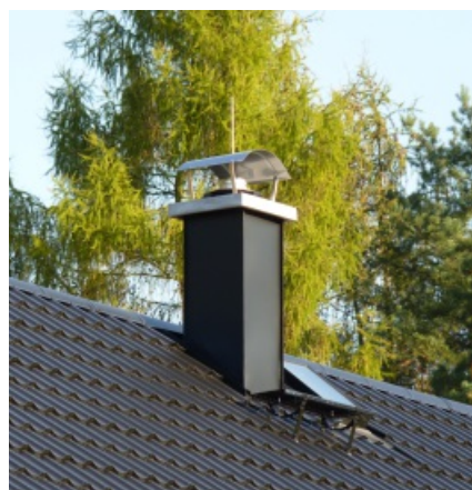
Oplechovaná základ nadstřešní část s oblou stříškou
