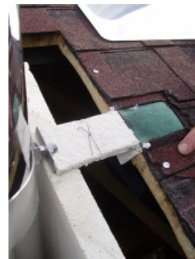
Příklad uchycení střešního držáku
