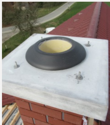
Příšroubovaná krycí deska pro přívod vzduchu
