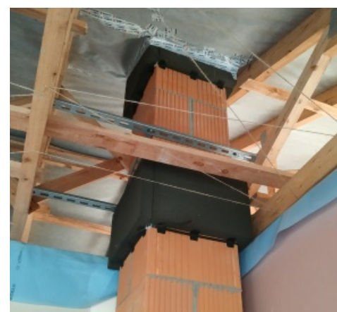
Parotěsné prostupy na cihelném komíně
