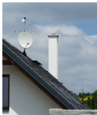
Omítnutá základní nadstřešní část
