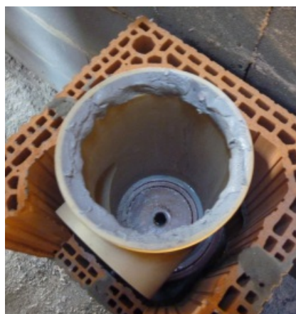
Spárovací hmota v hrdle vložky CIKO TEC
