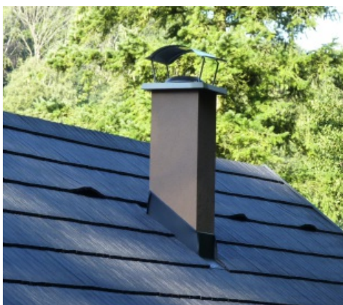
Omítnutý základ s oblou stříškou
