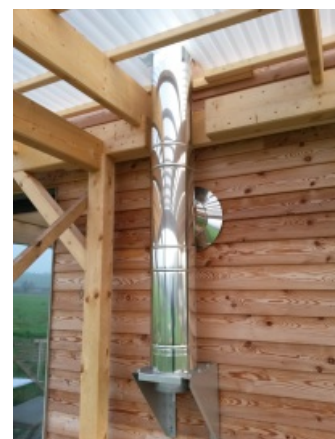
Nerezový komín založený na konzoli
