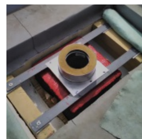
Detail založení v ploché střeše
