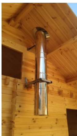
Příklad založení svislého kouřovodu
