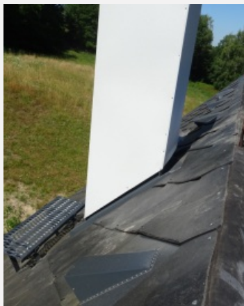
Detail přesazení náleku štuko přes lemování
