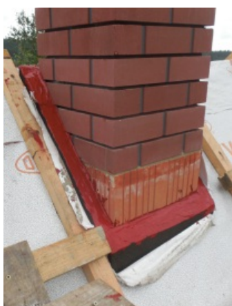
Parotěsný průstup cihelného komína
