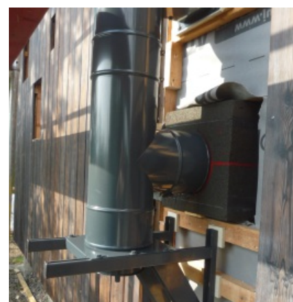
Parotěsný vstup kouřovodu
