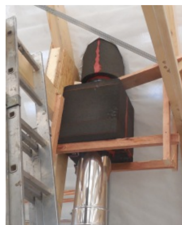
Parotěsné prostupy na nerezovém komíně
