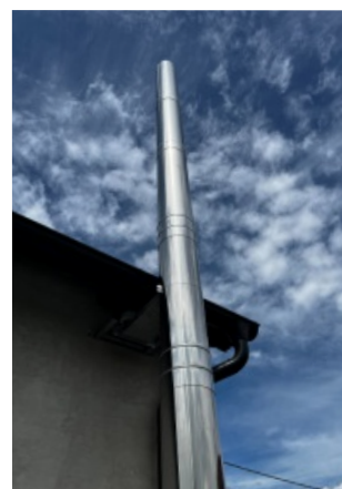
Statické spony pro volné vyložení až 4 m
