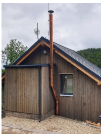
Galvanicky poměděný fasádní nerezový komín
