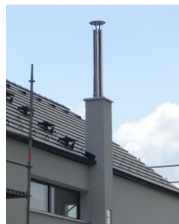
Nerezový nástavec založený nad střešou
