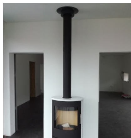
Lakovaný svislý kouřovod s funkcí komína
