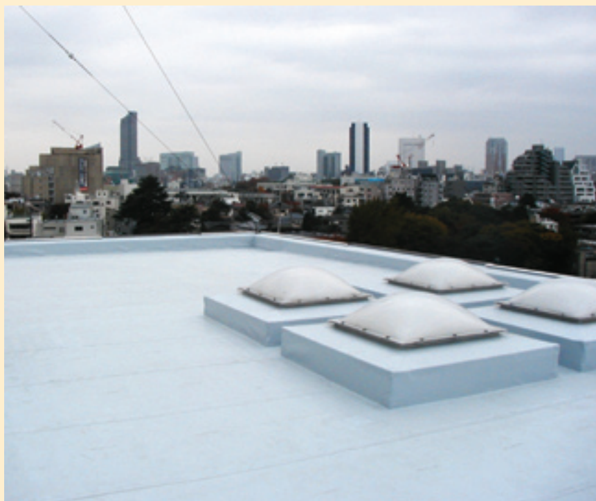
Hydroizolační fólie typu EVA (etylen-vinyl-acetát) EVALON V. Střecha budovy zastupitelského úřadu ČR a SR v Tokiu
