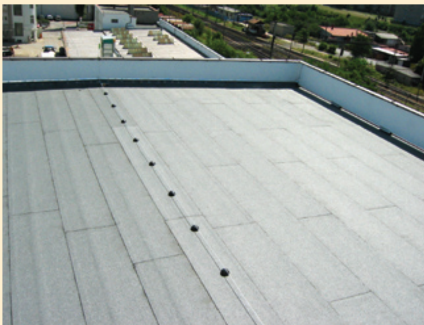
Skladový objekt firmy JUBEL v Praze 10
