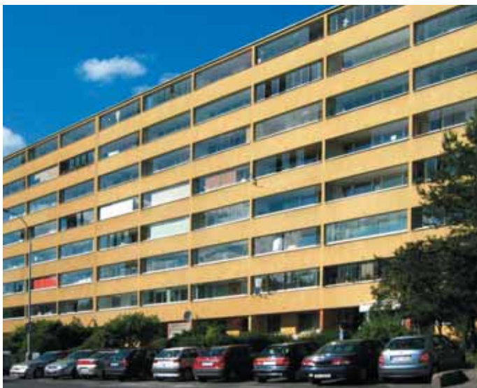
Obr. 12: Bytový dům s lodžiami opatřenými zasklívacím systémem
