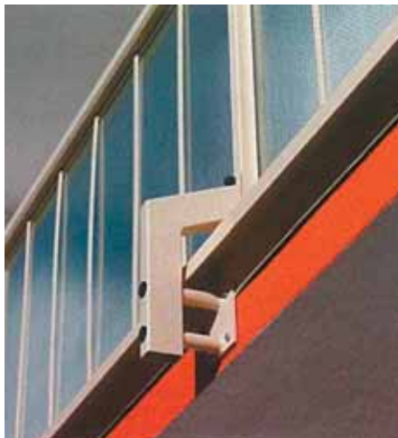
Obr. 10: Kotvení sloupky zábradlí
