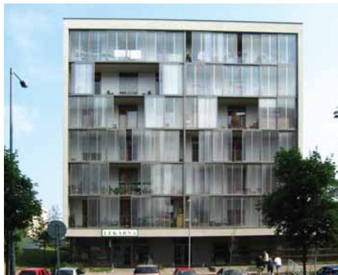
Obr. 13: Netypický způsob zasklení lodžii
