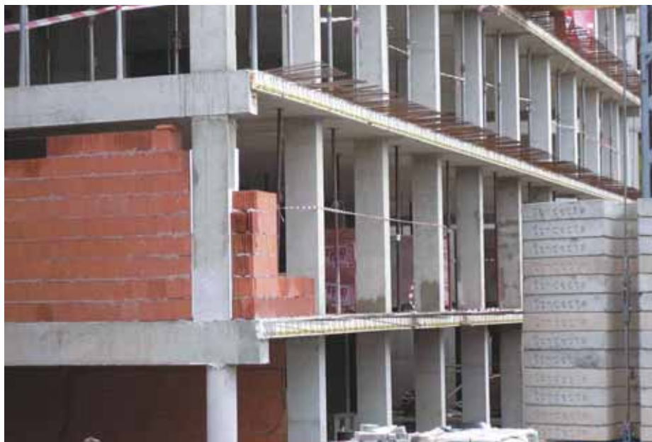
Obr. 9: Zabudované izonosníky Schöck Isokorb
