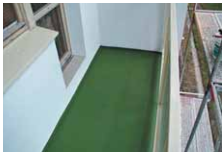
Obr. 12: Betonová mazanina s povrchovou úpravou
