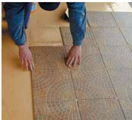
Obr. 2: Pokládka dlažby do lepicí malty
