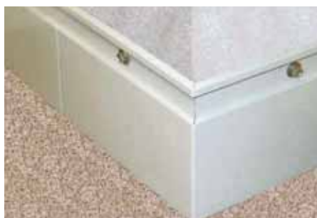
Obr. 24: Stěnový ukončující profil Alwitra – slitina Al-Mg-Si
