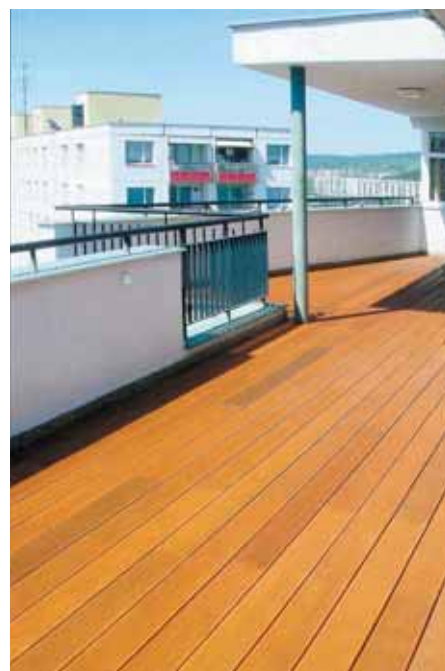
Obr. 8: Terasa s palubovou podlahou
