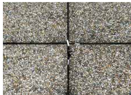
Obr. 6: Nedopalky cigaret ve spárách dlažby na podložkách na veřejně přístupné terase
