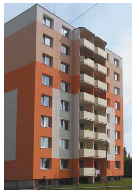
Obr. 3: Montované železobetonové lodžie ŽPSV
