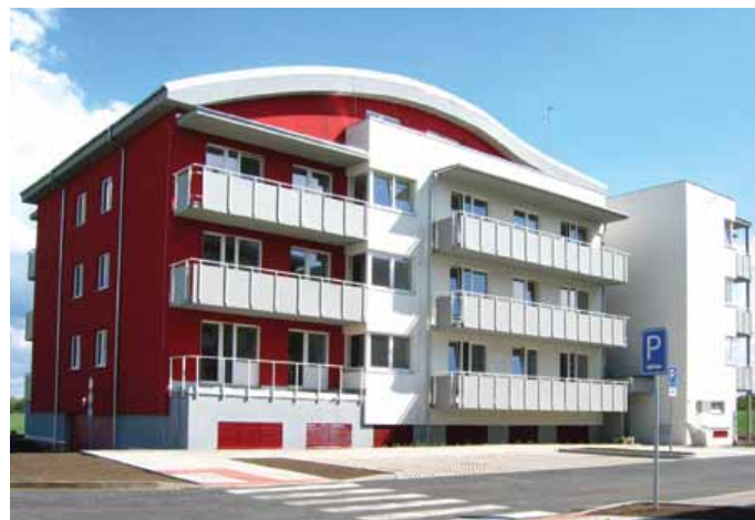
Obr. 8: Bytový dům s balkóny a terasami
