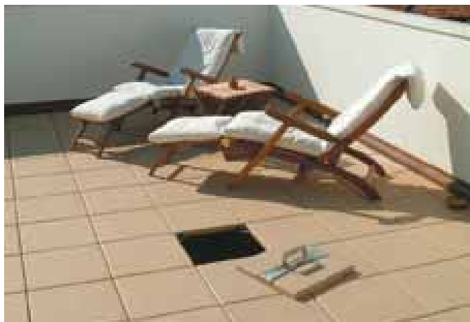
Obr. 7: Dlažba na podložkách. V případě potřeby je snadno demontovatelná.
