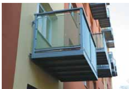
Obr. 5: Závěsné balkóny ZB VENTURE 02. Držitelem práv k této balkonové technologii a dodavatelem je firma VENTURE BRNO, s. r. o.
